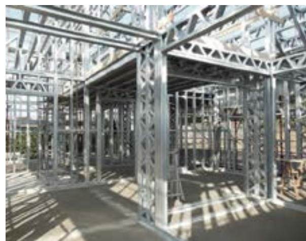
Struttura di abitazione a due piani in costruzione
