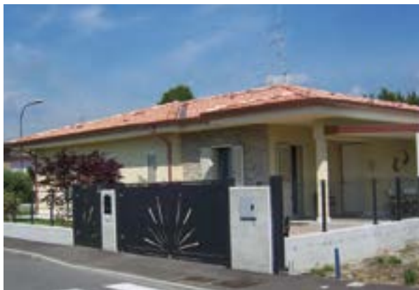
Villa bifamiliare a Trecenta
